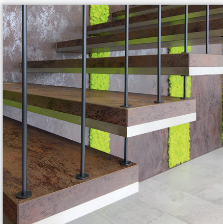
Schody wspornikowe – stopnie spiek kwarcowy + stal nierdzewna szlifowana, balustrada harfowa, pochwyt nierdzewny.
