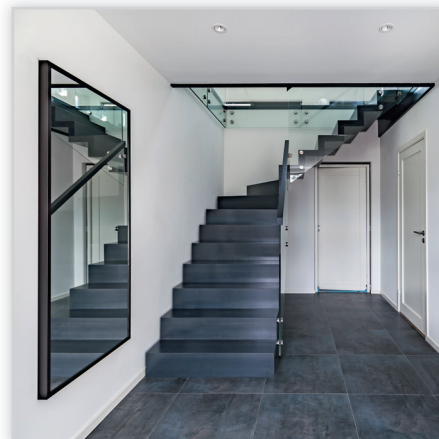
Schody dywanowe – dąb bejcowany, lakier półmat, balustrada szklana Flat z pochwytym drewnianym o przekroju prostokątnym.
